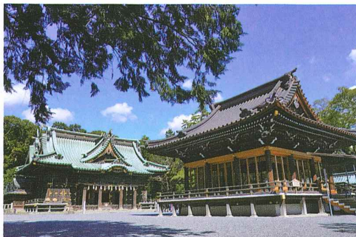
修復された舞殿とこれから修復される本殿・幣殿・拝殿
